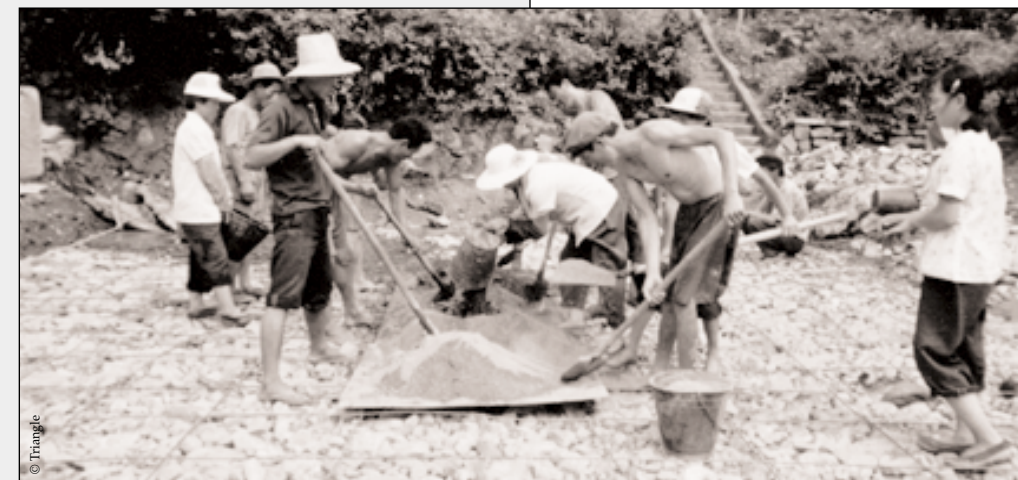
Construction de fumière
