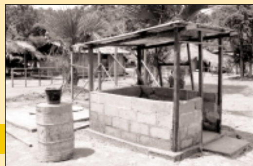
1ère latrine Triangle G H en cours de construction
